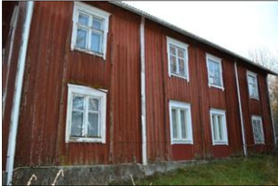
Julkisivu koilliseen (Tiina Lehtisaari 13.11.2013)
