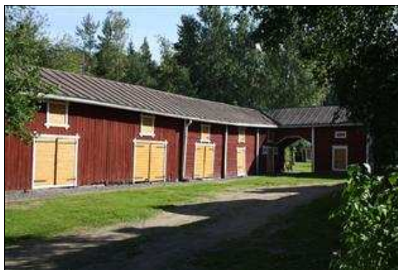
Tamminmäki II:n liiveri ja sauna pohjoisesta kuvattuna. (Saana Lind 24.10.2013)
