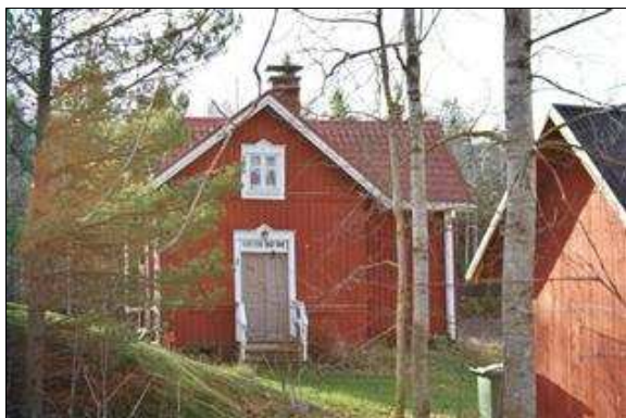
Salmivirran asuinrakennus koillisesta kuvattuna. (Saana Lind 29.10.2013)
