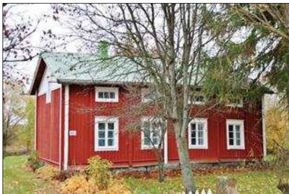
Jokipellon asuinrakennus pohjoisesta kuvattuna. (Saana Lind 17.10.2013)
