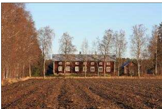
Rengon asuinrakennus lounaasta kuvattuna. (Tiina Lehtisaari 11.11.2013)
