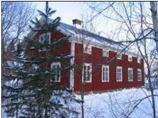
Talo on rakennettu 1892 ja peruskorjattu 1960-luvulla. (Susanne Öst 12.02.2007)
