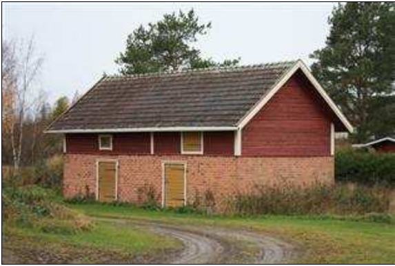
Peltoniemen talousrakennus koillisesta kuvattuna. (Saana Lind 17.10.2013)
