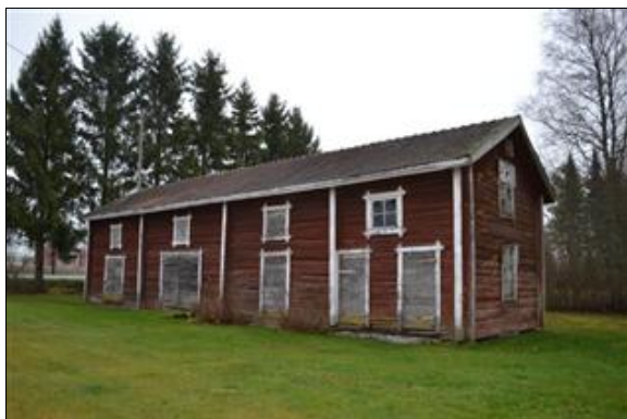
Rakennus kuvattuna lännestä (Tiina Lehtisaari 1.11.2013)
