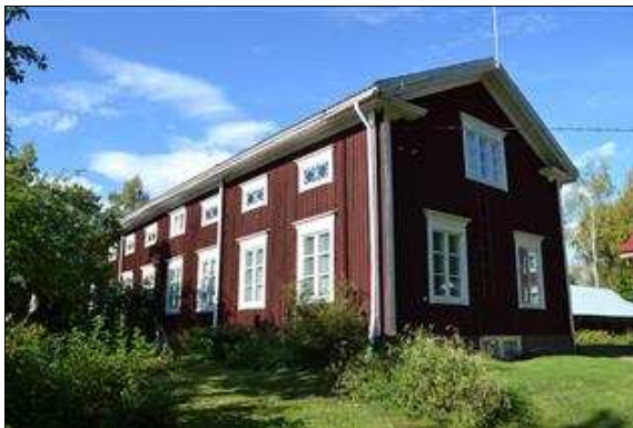
Pispan asuinrakennus etelästä kuvattuna. (Saana Lind 10.09.2013)
