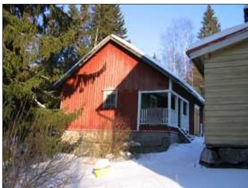
Rakennuksen länsipääty. (Susanne Öst 12.02.2007)
