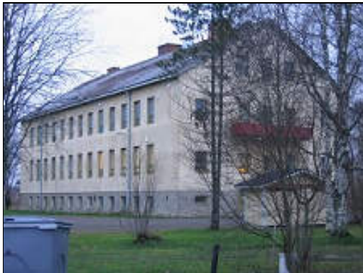
Kohteen lounaan puoleinen julkisivu (Sari Tallgren 12.11.2007)
