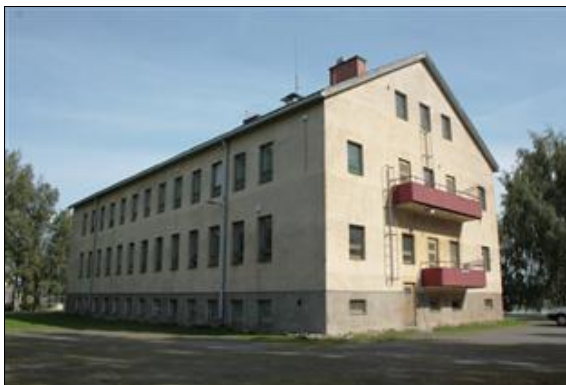
Kotiteollisuuskoulun päärakennus lounaasta kuvattuna. (Saana Lind 6.8.2013)
