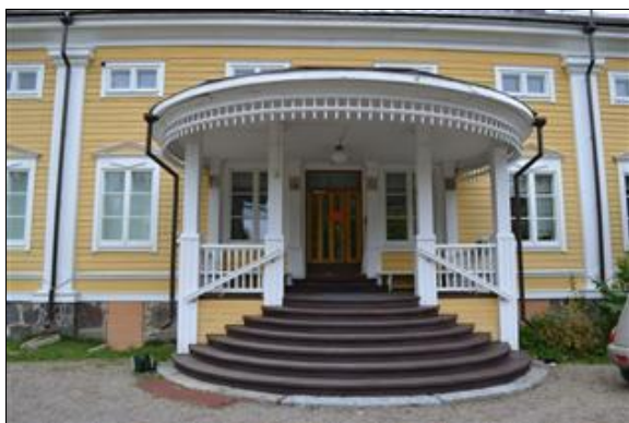
Pääjulkisivulla, pohjakyröntien suuntaan, sijaitsee kaunis avokuisti (Tiina Lehtisaari 26.09.2013)
