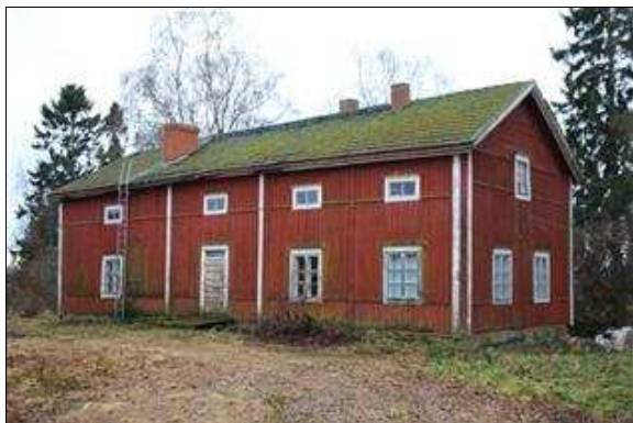
Plukan asuinrakennus pohjoisesta kuvattuna. (Saana Lind 08.11.2013)
