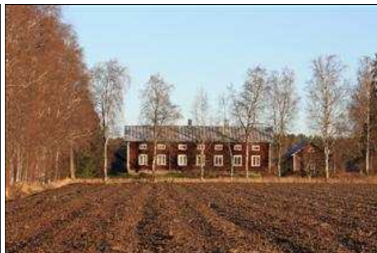
Rengon asuinrakennus lounaasta kuvattuna. (Tiina Lehtisaari 11.11.2013)
