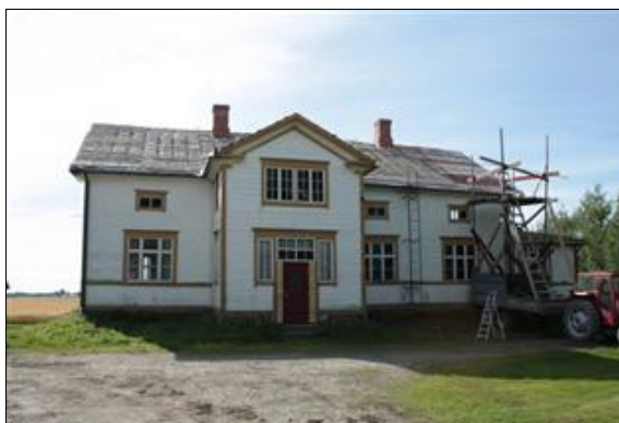
Ala-Taanolan asuinrakennus pohjoisesta kuvattuna. (Saana Lind 6.8.2013)
