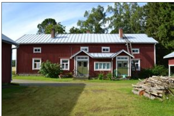
Ala-Komsin asuinrakennus koillisesta kuvattuna. (Saana Lind 14.8.2013)
