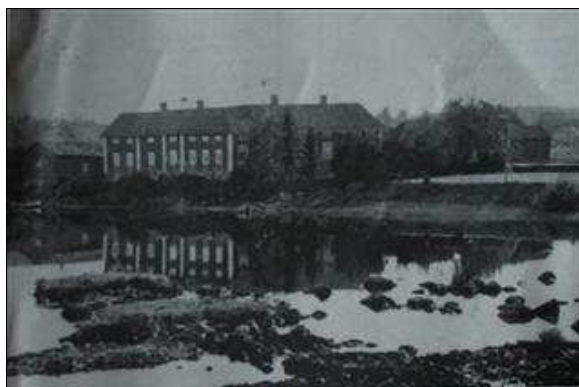
Knaapin asuinrakennus koillisesta kuvattuna (kuva otettu ennen vuotta 1928). (Saana Lind 26.8.2013)
