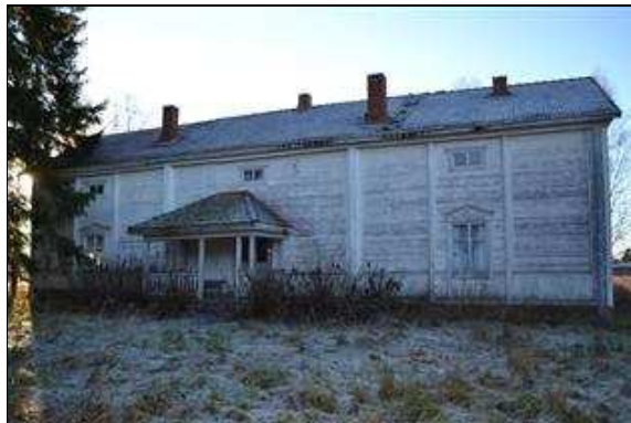
Julkisivu pihaan päin, koilliseen (Tiina Lehtisaari 11.11.2013)
