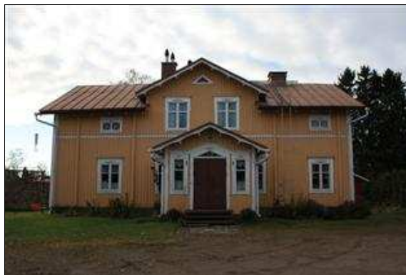
Ylimäen asuinrakennus idästä kuvattuna. (Saana Lind 25.10.2013)
