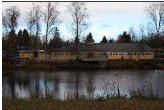
Pukkilansaaren kiinteistö lounaasta kuvattuna. (Saana Lind 25.10.2013)
