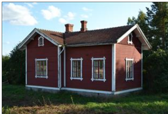
Kiskonvarren asuinrakennus pohjoisesta kuvattuna. (Saana Lind 20.8.2013)
