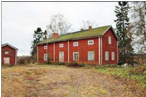
Plukan asuinrakennus pohjoisesta kuvattuna. (Saana Lind 08.11.2013)
