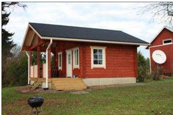
Ylimäen saunarakennus lounaasta kuvattuna. (Saana Lind 25.10.2013)
