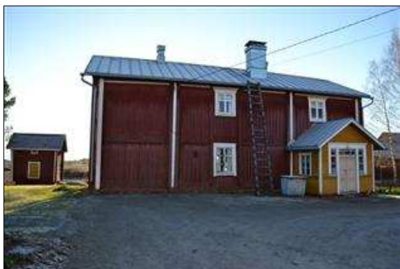
Julkisivu pihaan, pohjoiseen (Tiina Lehtisaari 11.11.2013)
