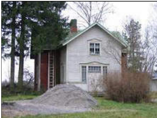
Kohteen pohjoisen puoleinen julkisivu (Sari Tallgren 13.11.2007)
