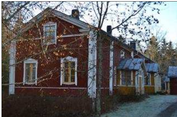
Rinta-Knuuttilan asuinrakennus koillisesta kuvattuna. (Tiina Lehtisaari 11.11.2013)
