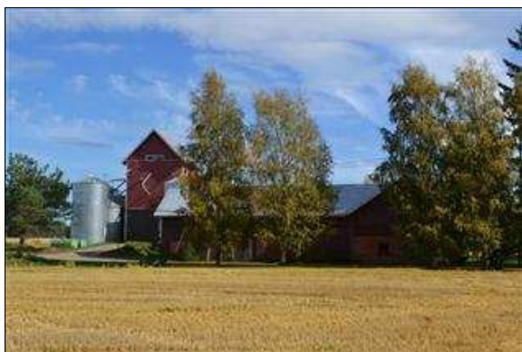
Yli-Nuujan navettarakennus ja kuivaaja lännestä kuvattuna. (Saana Lind 10.09.2013)
