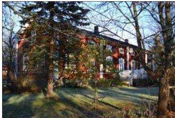
Rinta-Knuuttilan asuinrakennus lounaasta kuvattuna. (Tiina Lehtisaari 11.11.2013)
