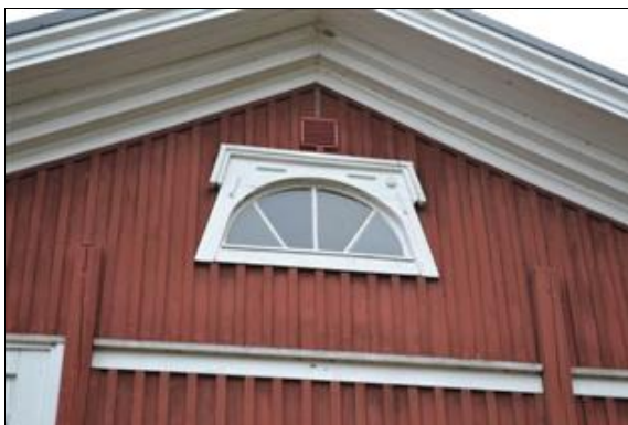
Päätyjen ullakkoikkunat (Tiina Lehtisaari 1.11.2013)
