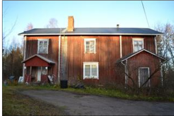
julkisivu pihaan, lounaaseen. (Tiina Lehtisaari 13.11.2013)
