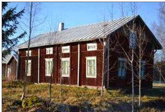
Vainio-Knuuttilan asuinrakennus idästä kuvattuna. (Tiina Lehtisaari 11.11.2013)
