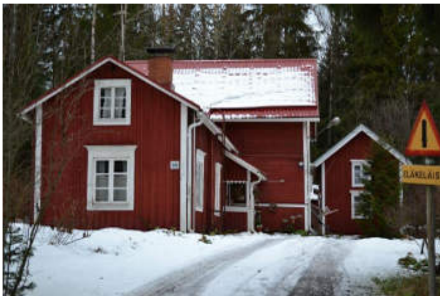
Väkkärinmäen pienasumukset ovat pääosin rakennettu 1800-luvun lopussa ja 1900-luvun alussa.
