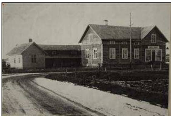
Myymälen asuinrakennus alkuaikoinaan. (Saana Lind 26.8.2013)
