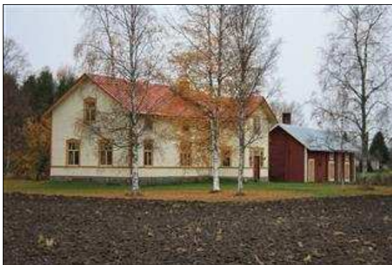
Peltoniemen asuinrakennus koillisesta kuvattuna. (Saana Lind 17.10.2013)
