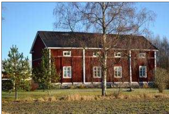
Uusi-Reinin asuinrakennus idästä kuvattuna. (Tiina Lehtisaari 11.11.2013)
