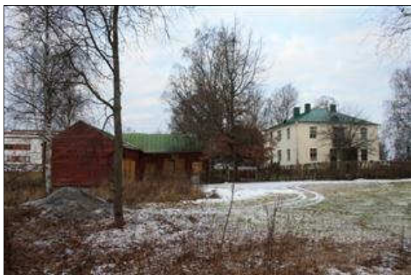
Tuomelan piharakennus ja päärakennus kaakosta kuvattuna. (Saana Lind 29.11.2013)
