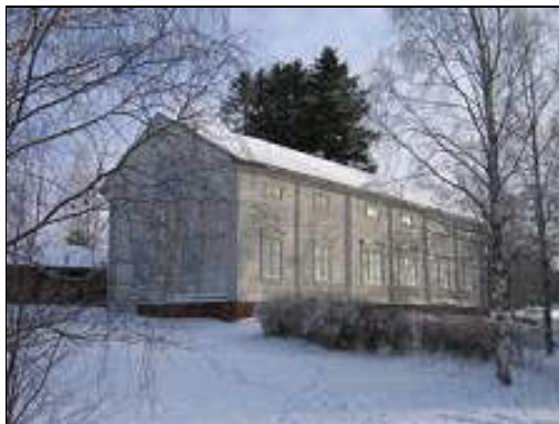
Päärakennus. (Susanne Öst 12.02.2007)
