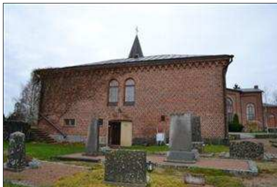
rakennus kuvattuna koillisesta (Tiina Lehtisaari 18.10.2012)
