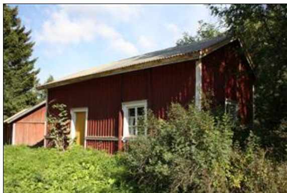
Hiekkamaanpalstan asuinrakennus lounaasta kuvattuna. (Saana Lind 23.8.2013)
