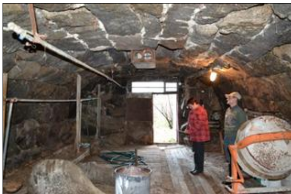
sisäkatto on holvattu (Tiina Lehtisaari 13.11.2013)
