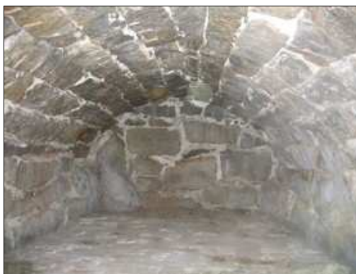
Rakennuksen alla on holvattu kivikellari. (Susanne Öst 12.02.2007)
