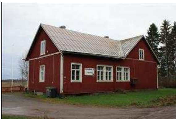
Kotovaion koulurakennus luoteesta kuvattuna. (Saana Lind 01.11.2013)
