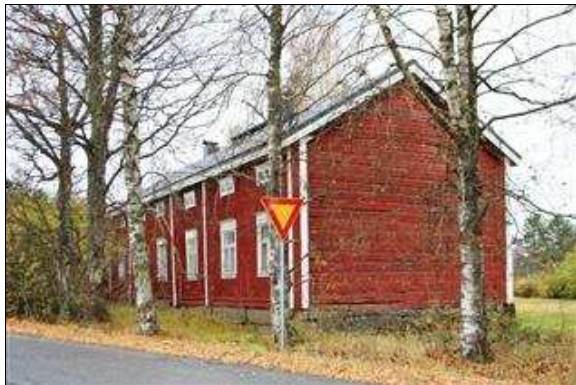
Takalan asuinrakennus koillisesta kuvattuna. (Saana Lind 17.10.2013)
