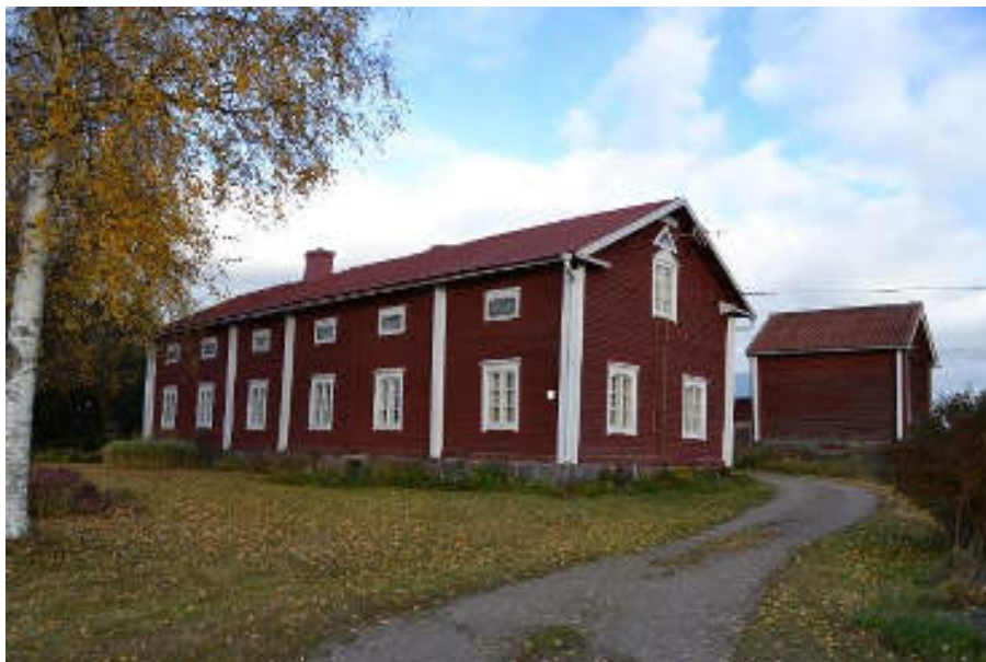
Kontsaan 1 ½ kerroksinen pohjalaistalo sijaitsee Palonkylässä ja se on rakennettu nykyiseen asuunsa vuonna 1862.
