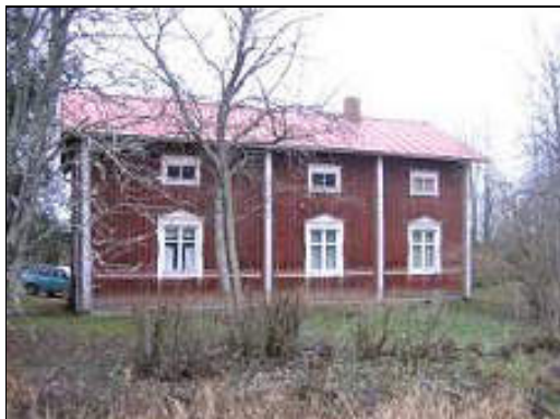
Kohteen läntinen julkisivu (Sari Tallgren 14.2.2008)
