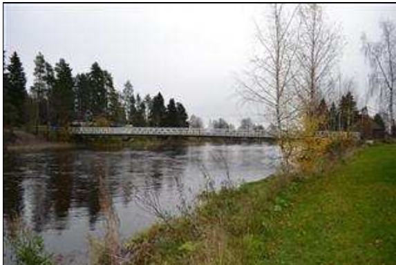
Perttilän silta kuvattuna luoteesta (Tiina Lehtisaari 18.10.2012)
