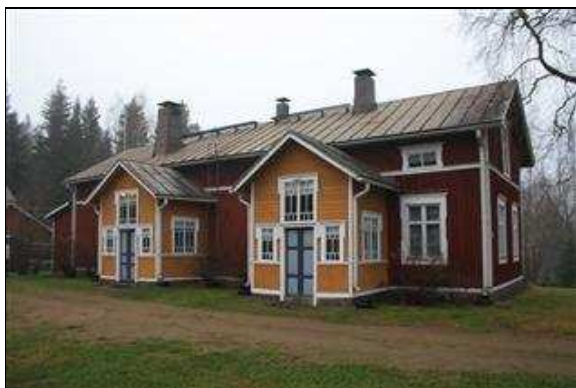
Tamminmäki II:n asuinrakennus koillisesta kuvattuna. (Saana Lind 29.10.2013)
