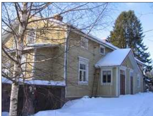
Pihanpuoleinen julkisivu. (Susanne Öst 12.02.2007)
