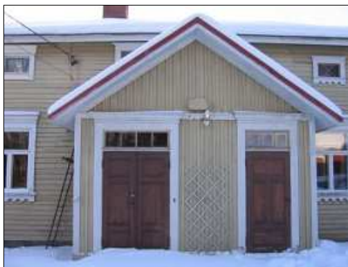
Kuisti ja pääsisäänkäynti. (Susanne Öst 12.02.2007)
